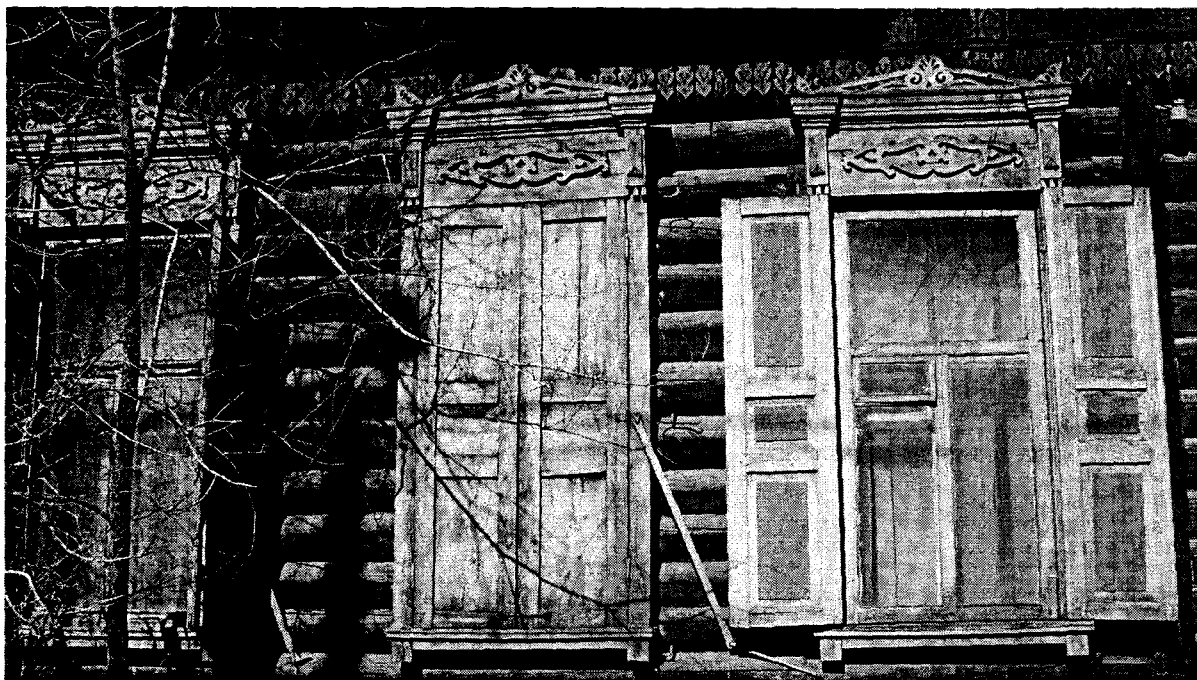
Фото 2 Фрагмент юго-западного фасада
