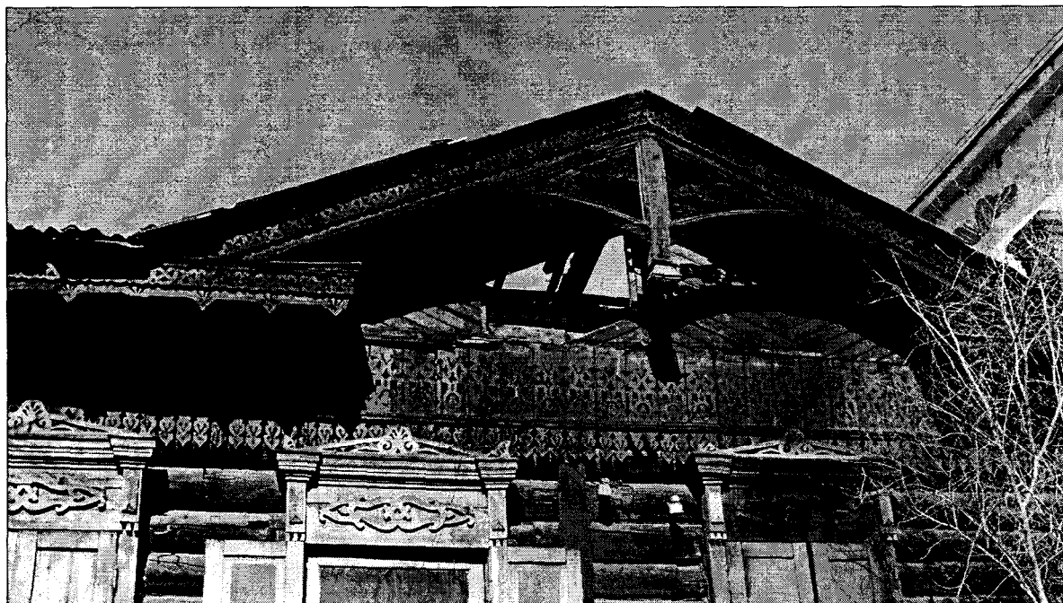
фото 3 Правый фронтон, главный фасад. Профильная резьба фриза, подзора, затяжки фронтона.
