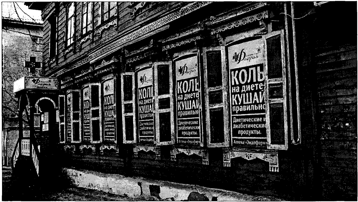
Фото 3 Фрагмент юго-западного фасада
