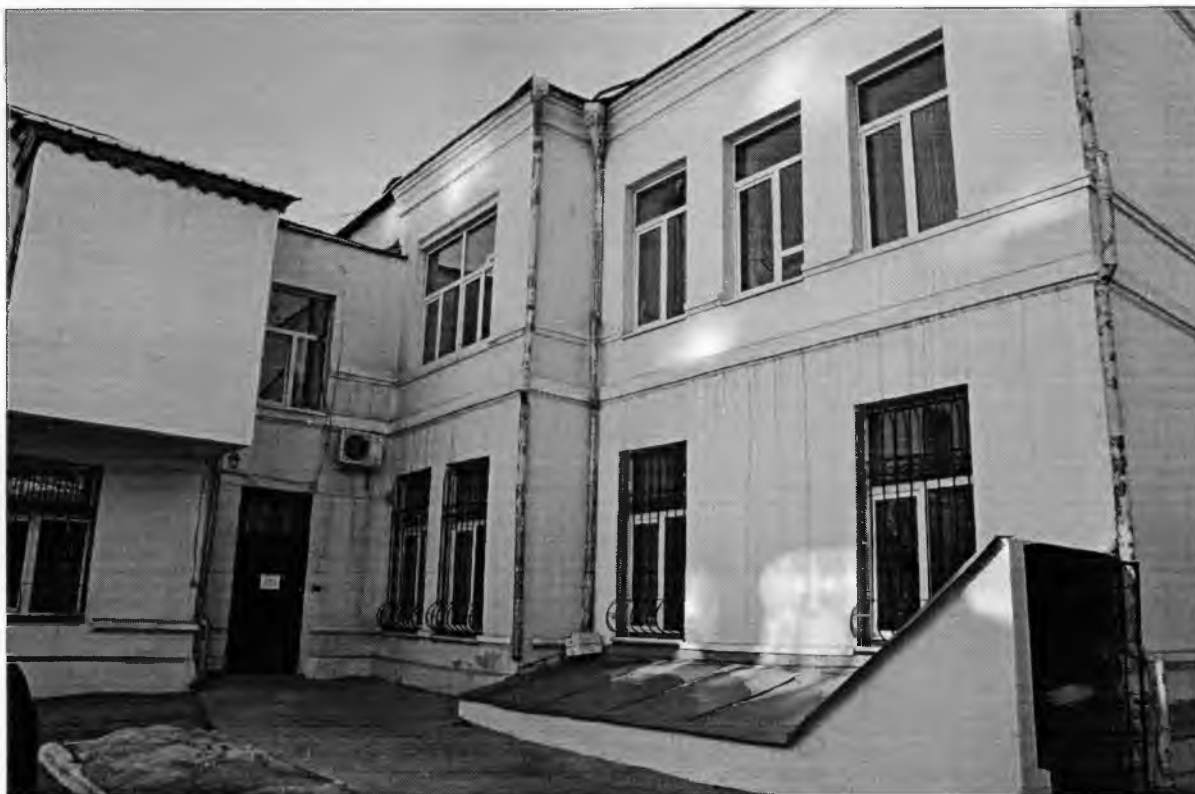
«Усадьба Коновалова. Дом доходный». Дворовый северо-восточный фасад.
