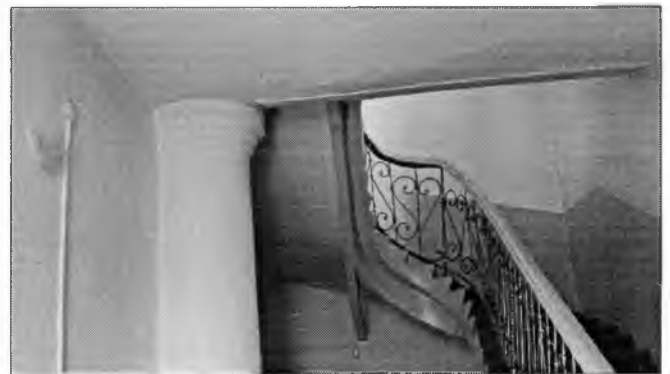
«Усадьба Коновалова. Дом доходный». Элемент конструктивной схемы. Колонна парадной лестницы.
